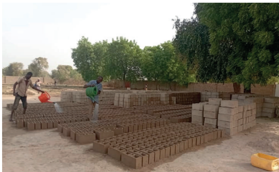
Burkina Faso : Confection des briques pour le futur Centre administratif.
