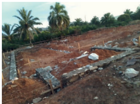
Site du futur internat.
