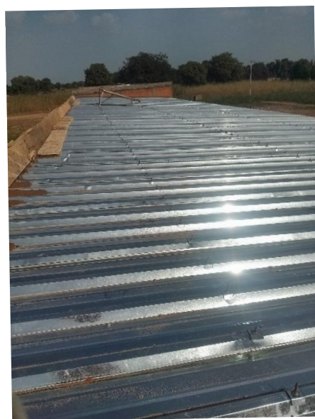
Le toit rénové
