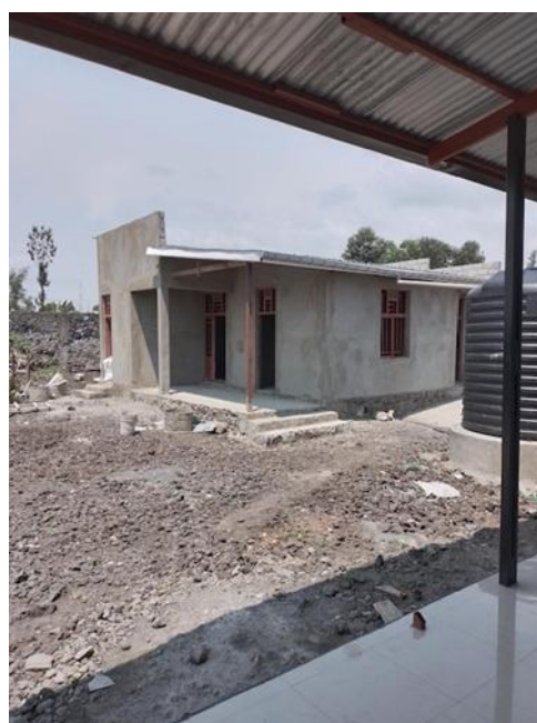
Le bâtiment en construction
