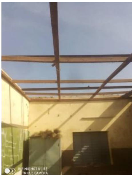
Les tôles de l'ancien toit sont enlevées.
