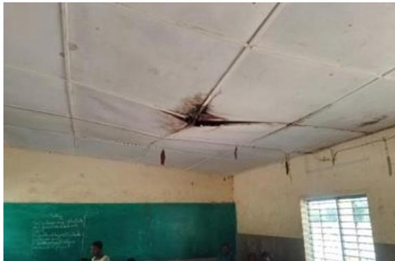
La réparation de la toiture par colmatage des entrées d'eau et des plafonds constitue une urgence car la saison des pluies a encore empiré la situation.
