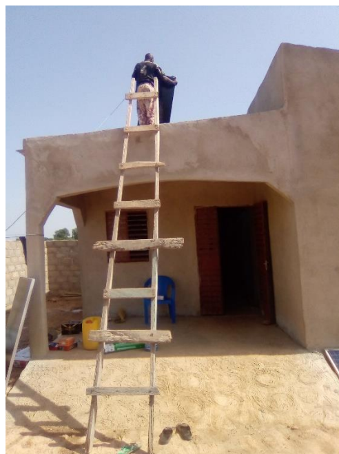
Pose de panneaux solaires
