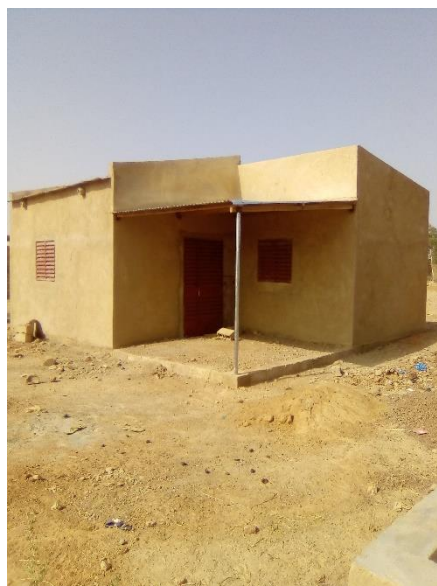
Maison de l'enseignant Gros-œuvre terminé
