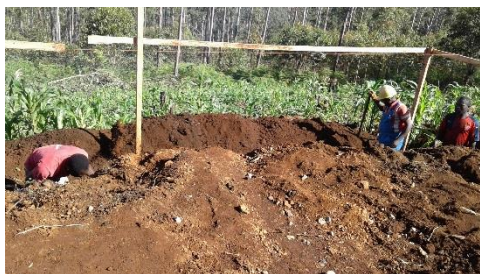
Creusement des fondations
