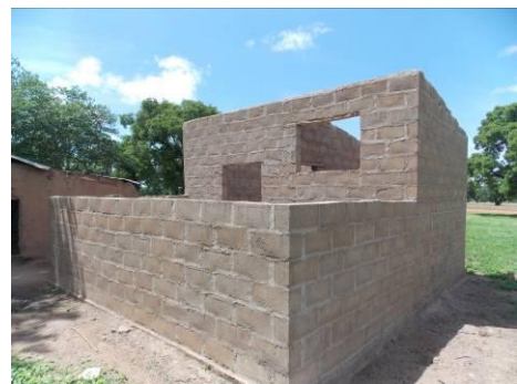
Les murs de la nouvelle cantine sont terminés
