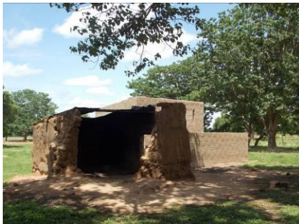
La nouvelle cantine se construit derrière l'ancienne
